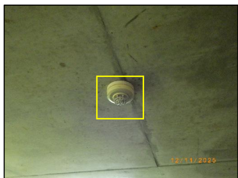
รูปที่ 2-43 เครื่องตรวจจับความร้อน
