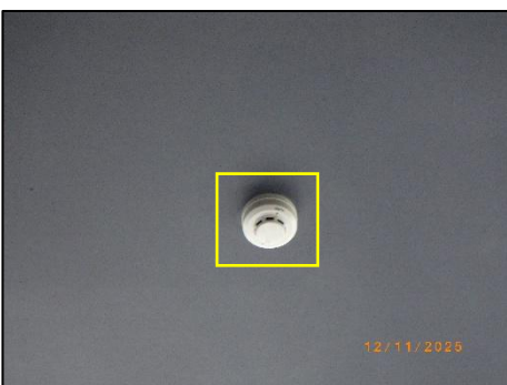
รูปที่ 2-42 เครื่องตรวจจับควัน
