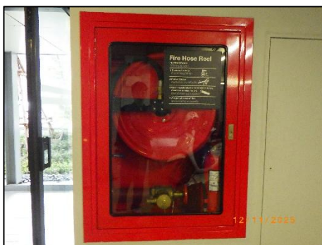
รูปที่ 2-46 ตู้เก็บสายฉีดน้ำดับเพลิง
