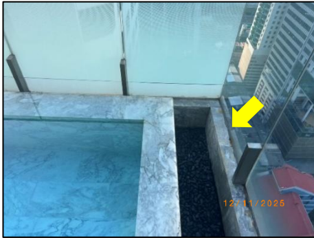
รูปที่ 2-80 รางระบายน้ำบนดาดฟ้า
