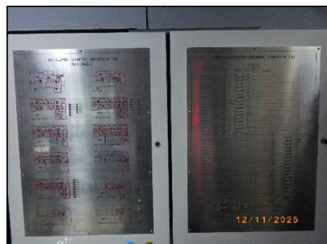
รูปที่ 2-41 แผงควบคุมระบบแจ้งเหตุอัคคีภัย
