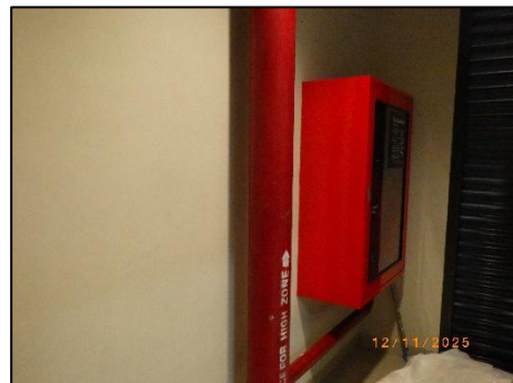
รูปที่ 2-44 อุปกรณ์ส่งสัญญาณแจ้งเหตุอัคคีภัย
