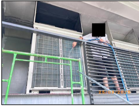
รูปที่ 2-19 การล้างเครื่องปรับอากาศ บริเวณพื้นที่ส่วนกลาง
