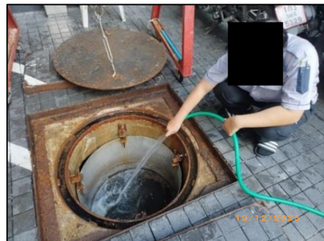
รูปที่ 2-32 การตรวจสอบและการทำความสะอาดบ่อดักน้ำ
