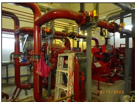
รูปที่ 2-48 เครื่องสูบน้ำดับเพลิง
