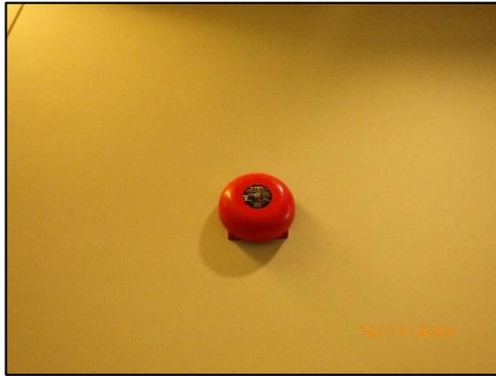
รูปที่ 2-44 อุปกรณ์ส่งสัญญาณแจ้งเหตุอัคคีภัย
