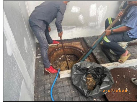
รูปที่ 2-30 การตรวจสอบและตัดไขมันในบ่อดักไขมัน
