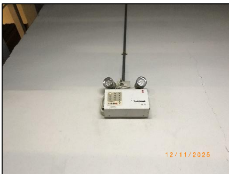
รูปที่ 2-54 ไฟส่องสว่างฉุกเฉิน
