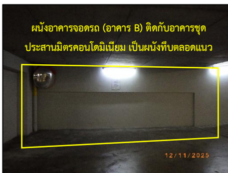
รูปที่ 2-7 ผนังกันไฟ ผนังอาคารจอดรถ อาคาร B
